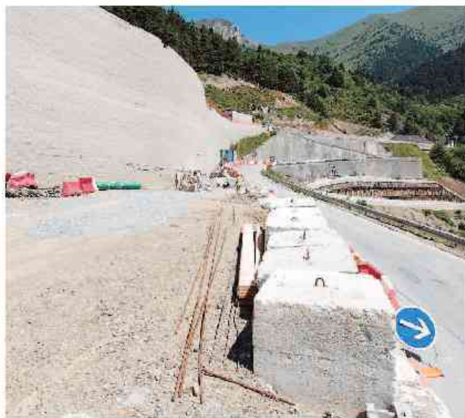
Il cantiere all'altezza degli ultimi tornanti in valle Roya
